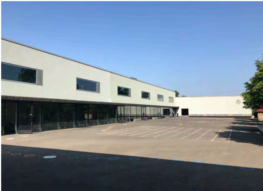
Abbildung 15: Erweiterter Schultrakt Brugglismatt 2
